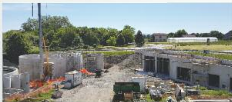
Le chantier de la nouvelle station
