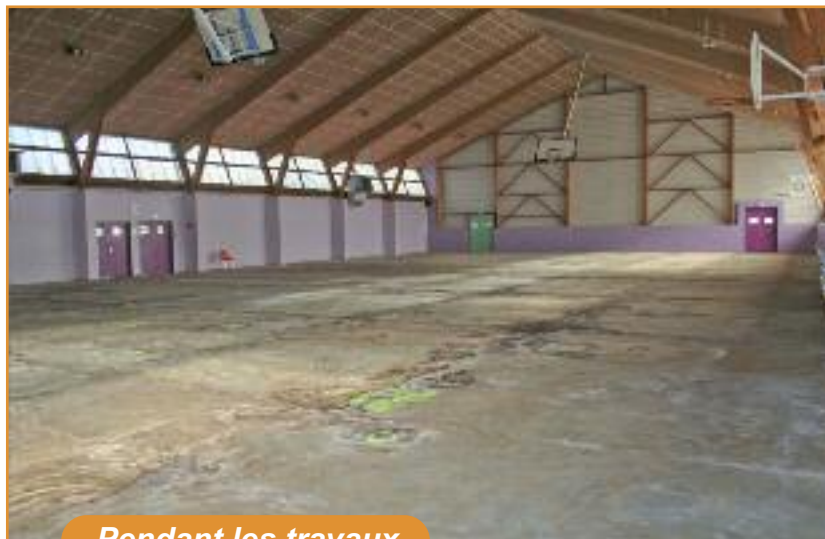
Pendant les travaux
