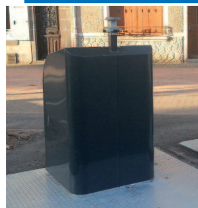
Mise en service le 2 juin 2014
