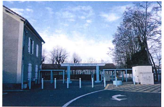
Photographie 2 : Entrée de l'école
