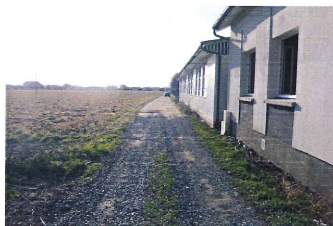
Photographie 6 : Vue sur le chemin à la limite sud du site
