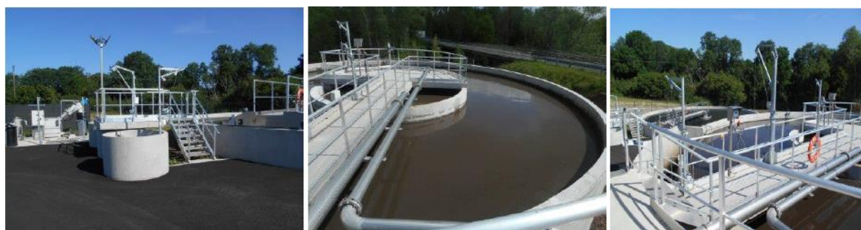
La STEP du bourg se situe route de Vichy, lieu-dit Les Gollards, 63350 Maringues
