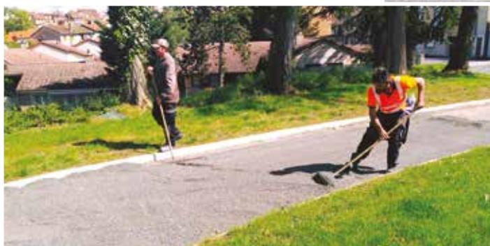
Le chemin a été recouvert de déchets de roche. Il s'agit en fait d'une revalorisation des déchets de roche concassée qui ne répondent pas aux calibres habituels d'exploitation, provenant du concassage de la pierre. L'utilisation d'un ma-
